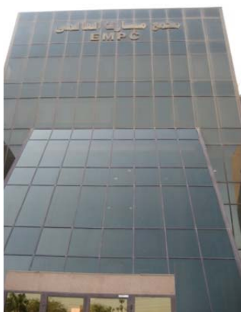
写真 1:EMPC の建物(報告者撮影)
