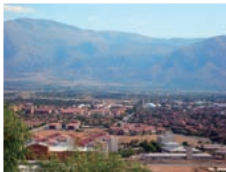
Reconstruction of Erzincan, Turkey, from 1992 earthquake 1992年の地震から復興したトルコ・エルジンジャン
